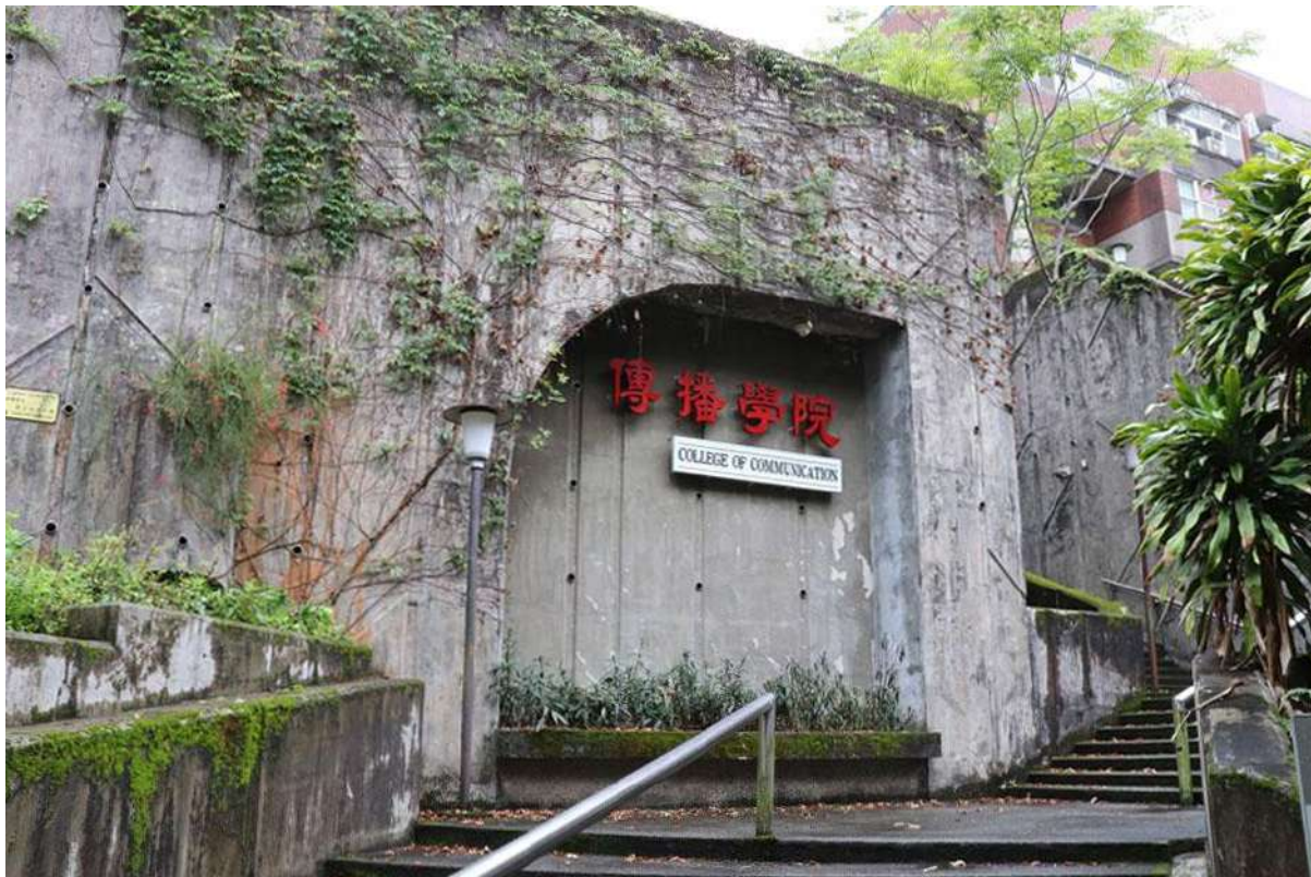
風零走廊連接傳播學院樓梯照片
